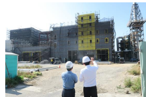
▲興建中的中區事廢處理中心二期工程
