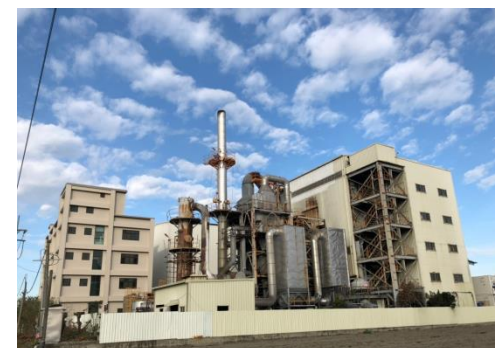
▲雲林二廠外部全貌
