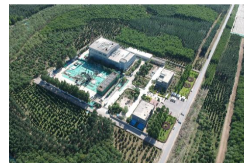
▲北京潤泰環保公司處理廠全貌
