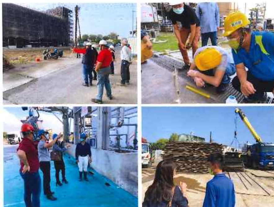
▲配合發包進度進行供應商實地訪廠及溝通施工事項
