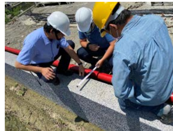
▲定期巡檢，確實要求廠商注重廠內作業安全
